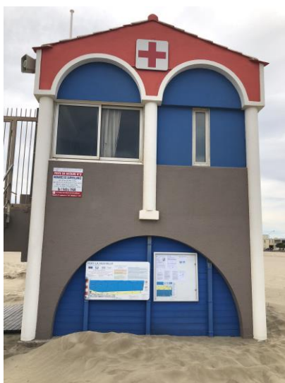
Poste de secours n°2
