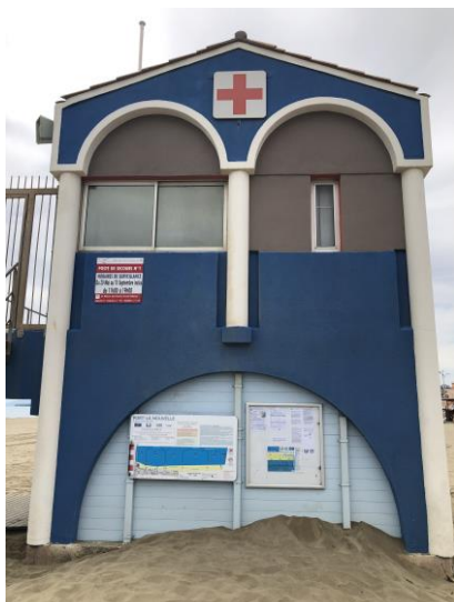
Poste de secours n°1
