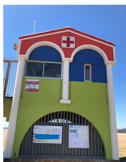
Poste de secours n°3
