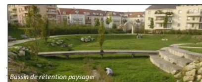
Bassin de rétention paysager
